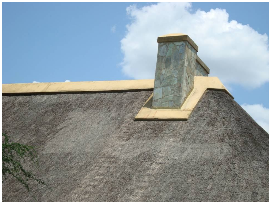
Aqui uma visão de conjunto do telhado e o detalhe da cumeeira
